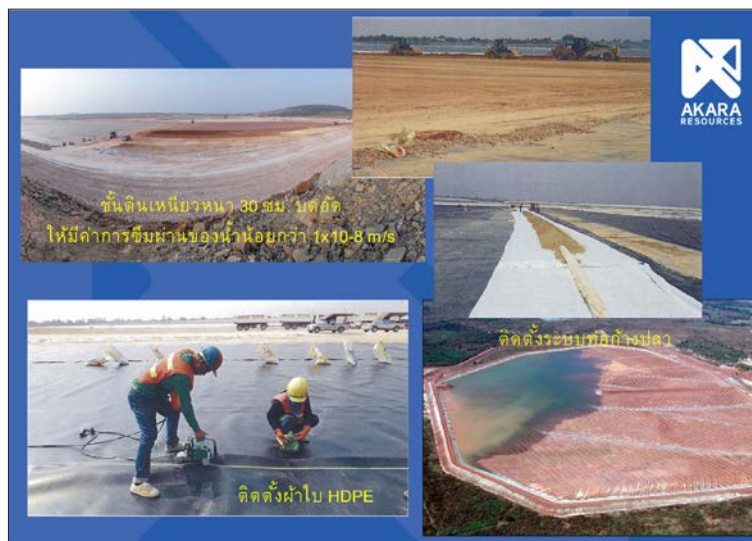
รูปที่ 1-1 การก่อสร้างบ่อเก็บกากแร่
